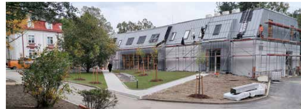
Nově postavená budova s jídelnou, kuchyní a internátem.
